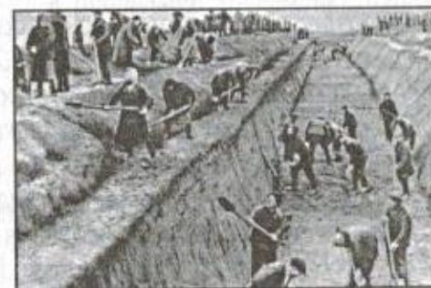
Рис. 17. Октябрь 1941 года. На строительстве противотанковых рвов
