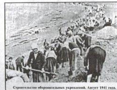
Рис. 18. На строительстве оборонительных сооружений
